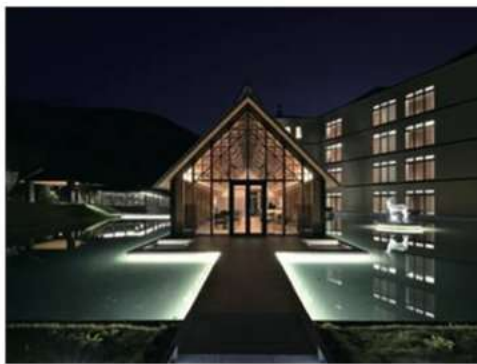
洞爺湖 鶴雅リゾート 洗の舘 水上ラウンジ「洗響」
